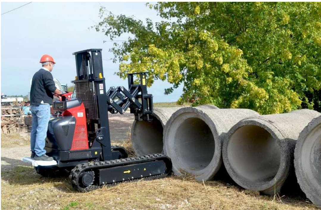
▼ Trasporto condotte in cemento circolari per acquedotti e fognature.
